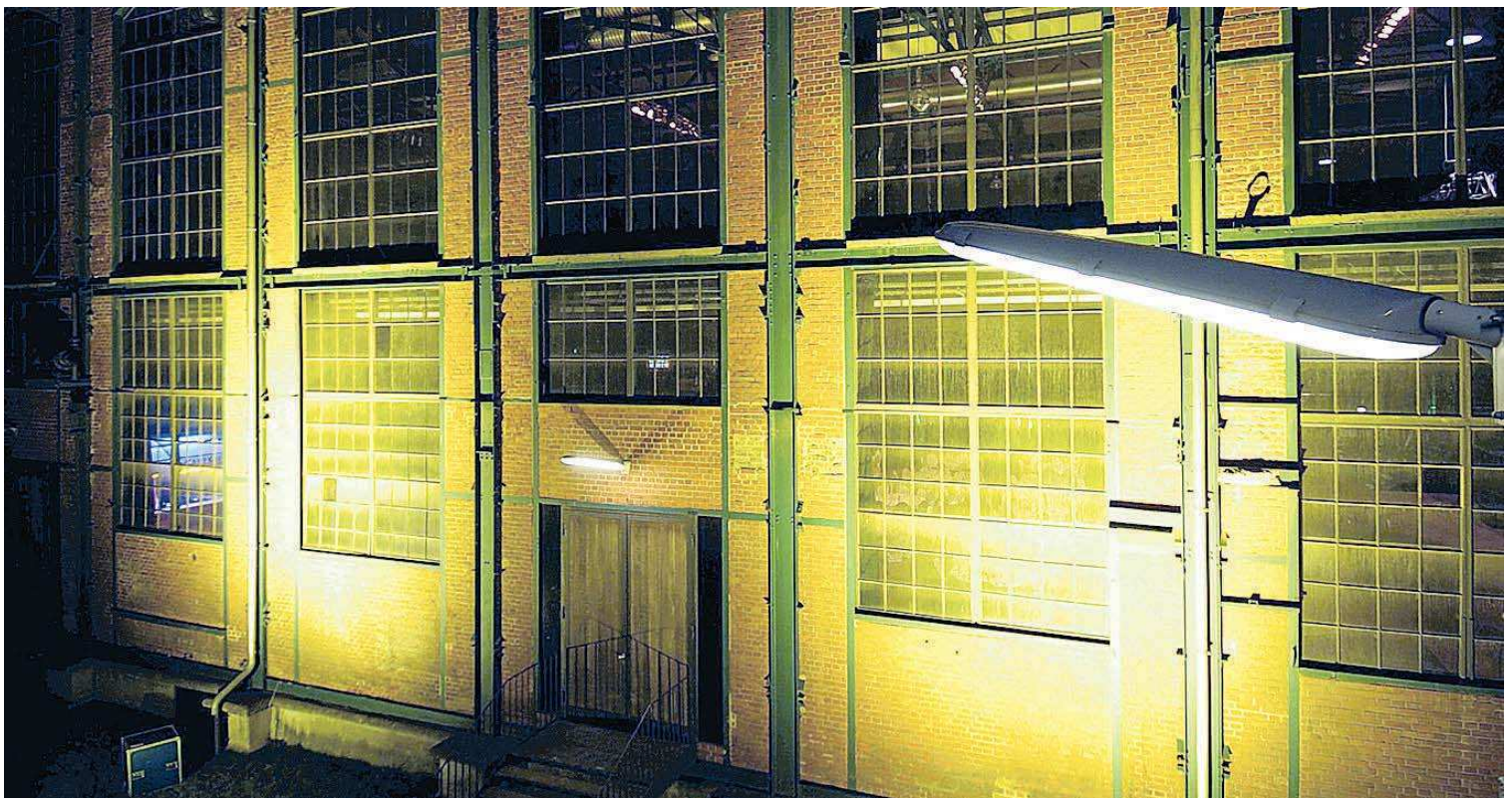
Das Saarbrücker E-Werk wird vom Förderverein „Konzerthaus Saarbrücken“ als Favorit gehandelt.
